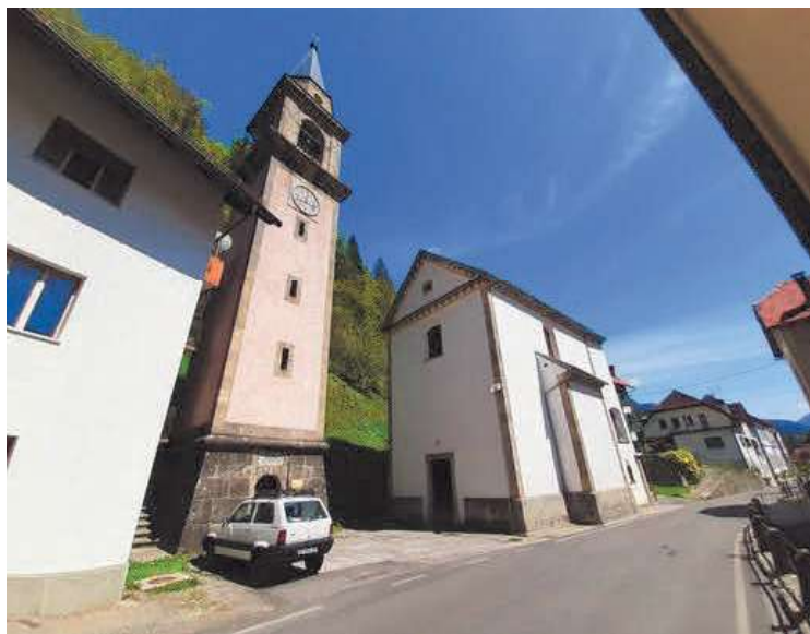
Foto 11 – Prato Carnico – Frazione Pieria Chiesa di Sant'Antonio di Padova.
