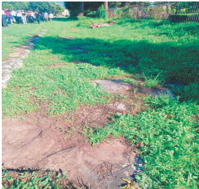
Strada romana: stato iniziale.
